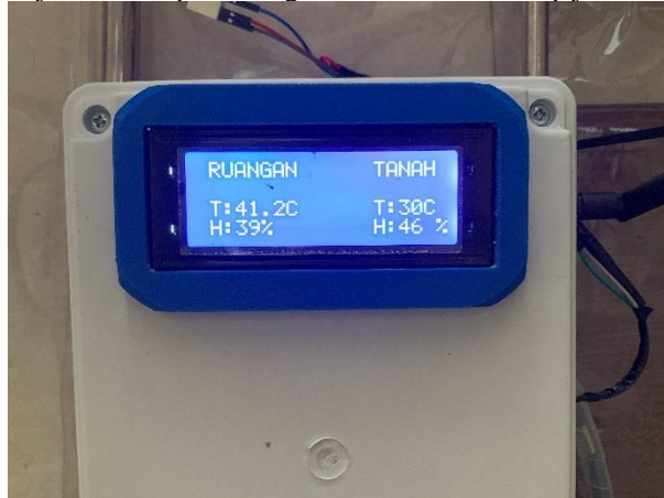
Gambar 5. Kondisi Relay 1 ON, Relay 2 ON dan Kecepatan Fan 100%
